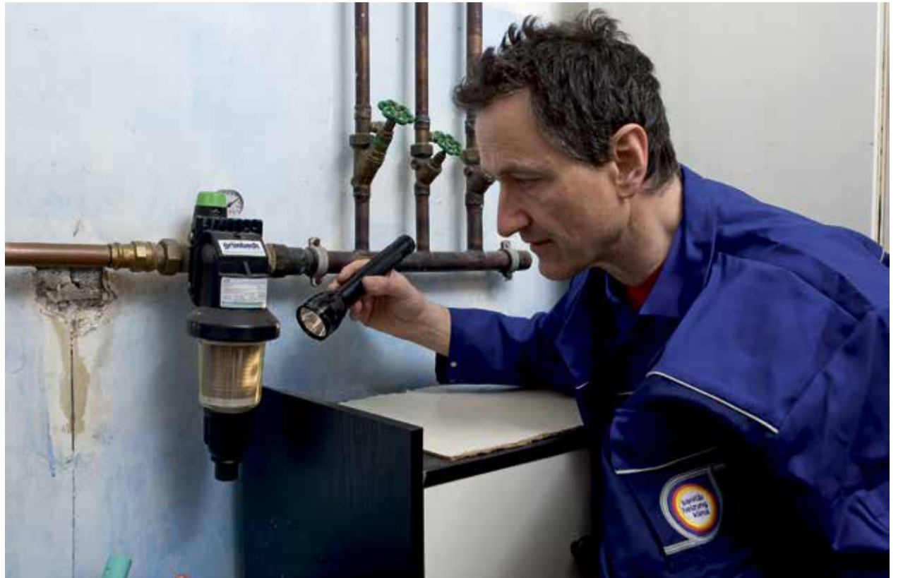
Der SHK-Fachmann prüft die Trinkwasser-Installation. Foto: ZVSHK
